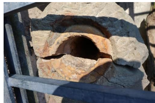
Sandsteinröhre der Wasserleitung
